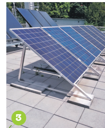
1,5 kWp csúcsteljesítményű napelemes rendszer.
