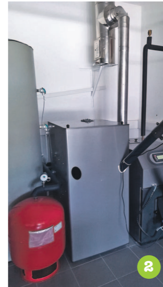
Pelletkazán és pellettároló automatikus felhordócsigával.
